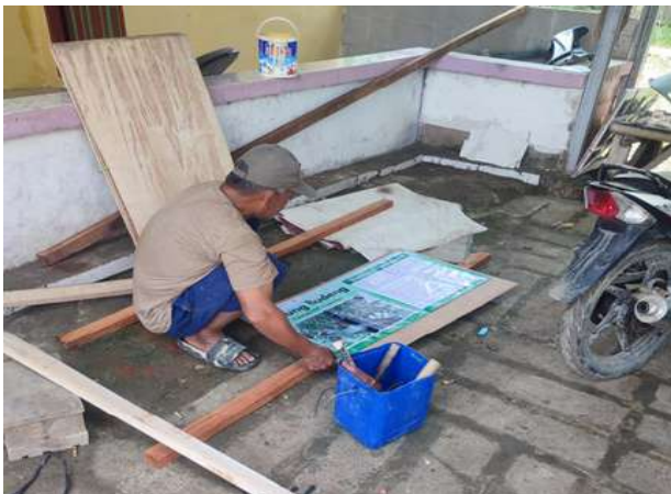
Gambar 4. Membuat kerangka fondasi papan informasi
